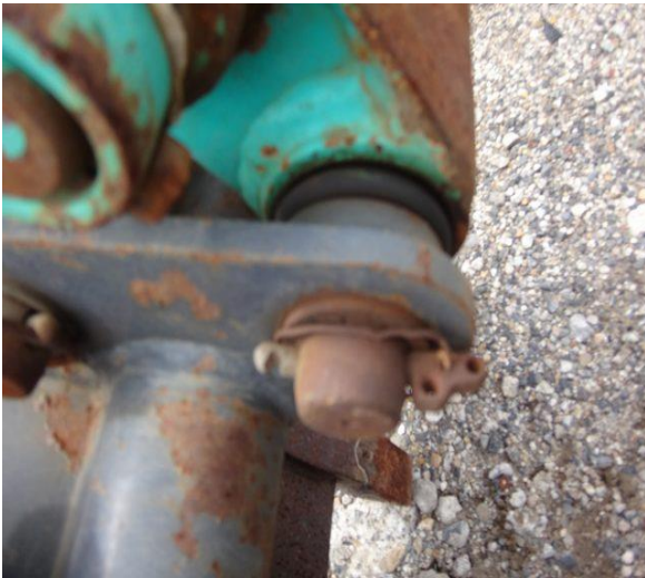
バケットピン留めストッパー損傷有り。
