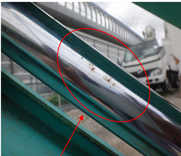
ブームシリンダーロッド錆打痕有り。
