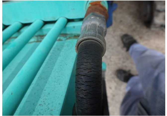
左右ブームシリンダー油圧ホースひび割れ有り。
